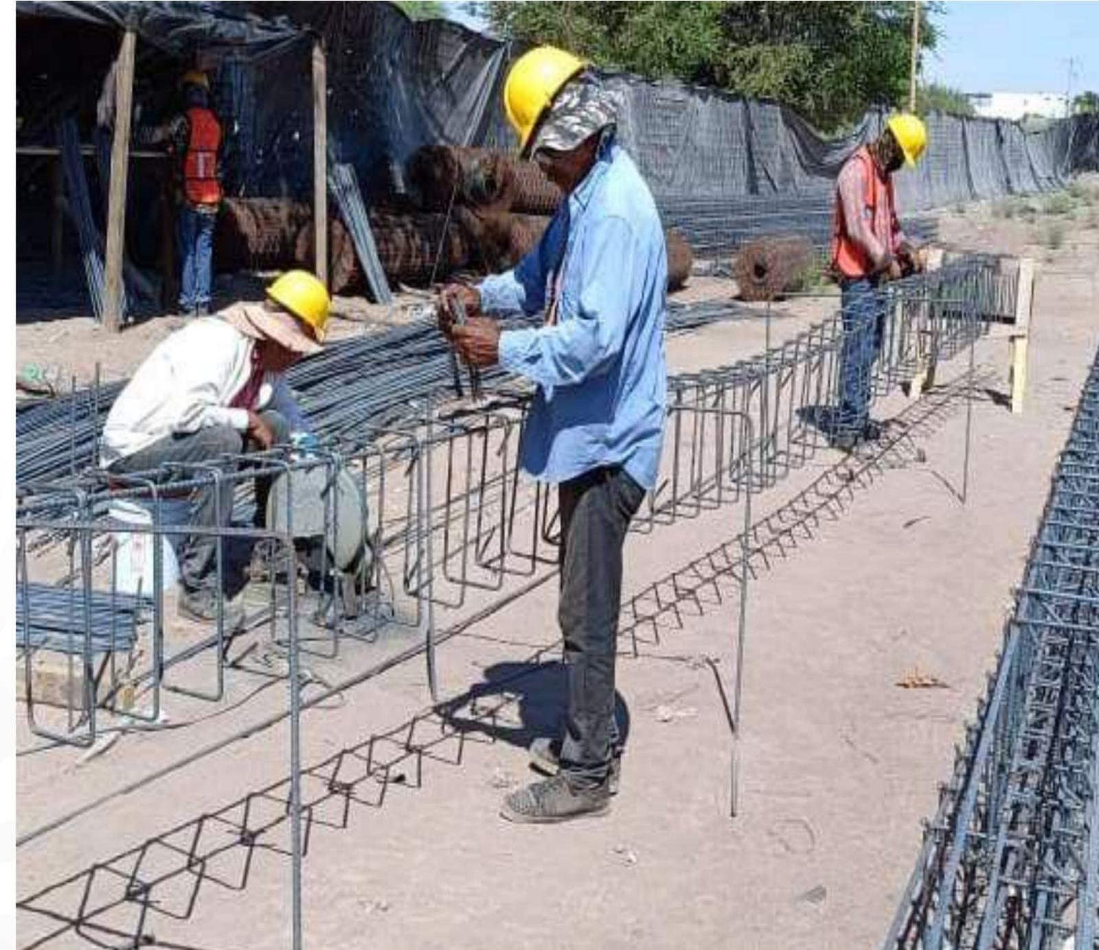
Habilitado y armado de acero de traveses de cimentación de plataforma
