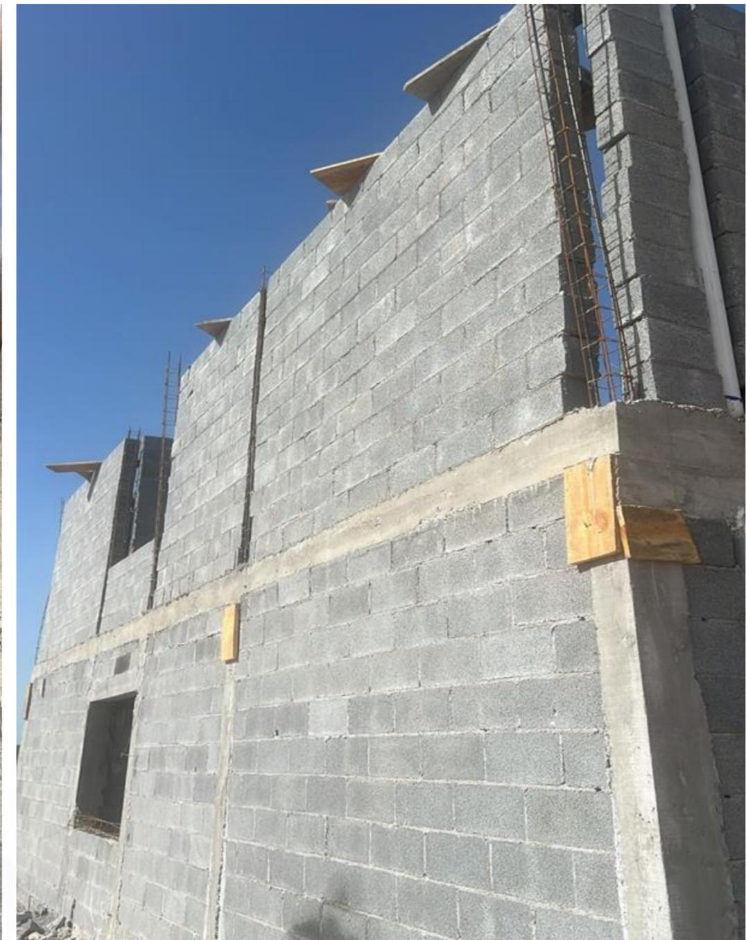
**Levantamiento de muros del nivel 2**
